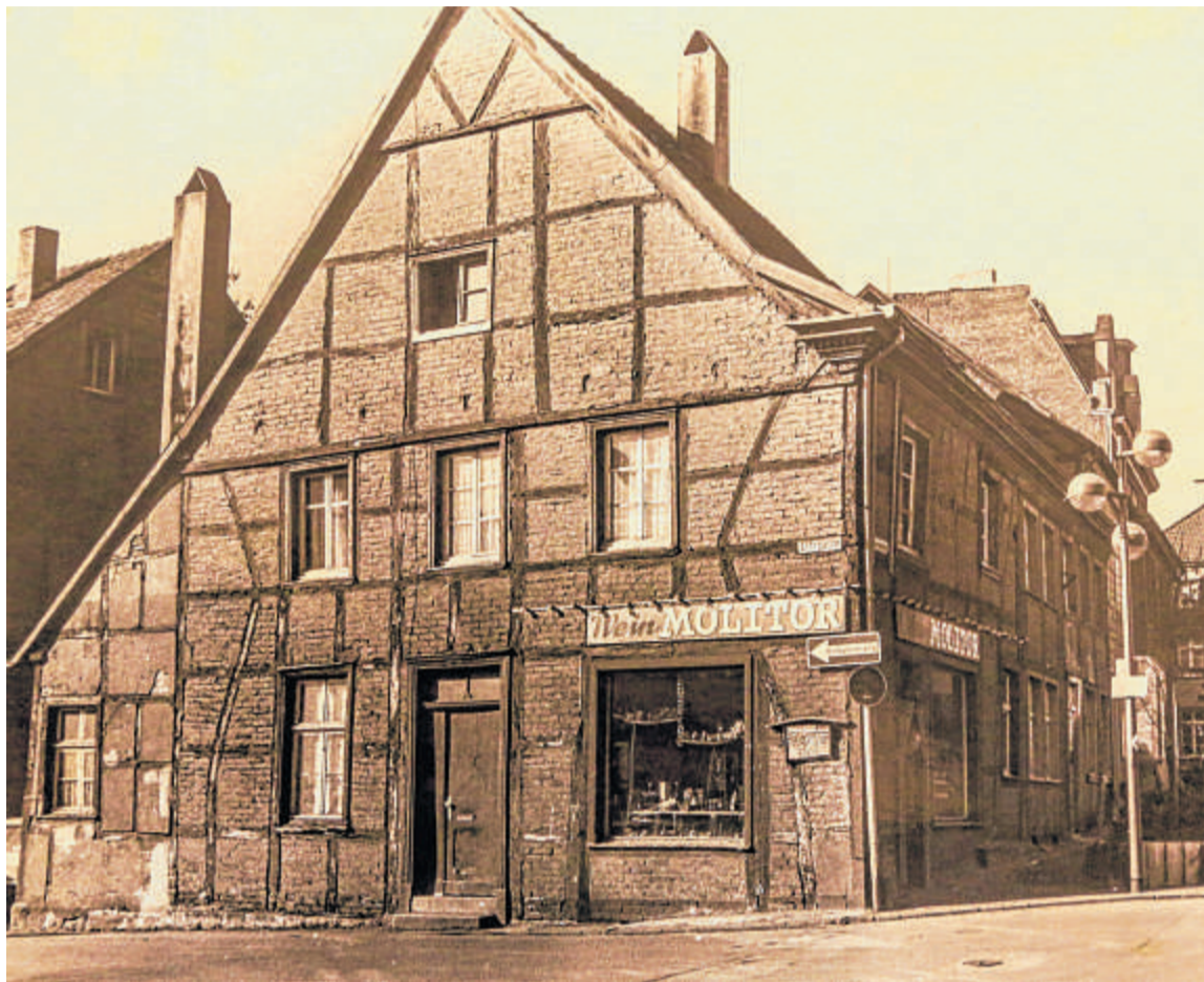
An der Löhnhofstraße befand sich ab 1975 die Filiale der Firma bis zum Abriss des Hauses.
